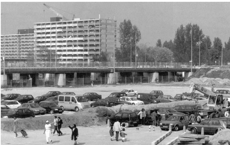
La cité Bijlmermeer, au sud-est d'Amsterdam. La ville y a lancé un vaste projet de réhabilitation.
